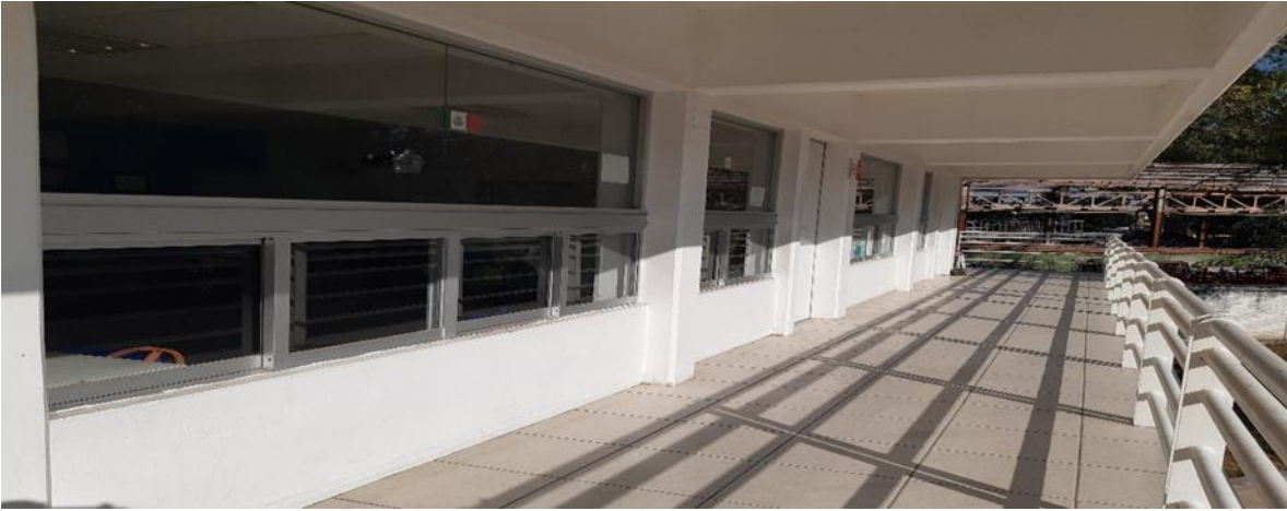
IMAGEN #6 ANTES DE LA INTALACION DE EXINGUIDORES
