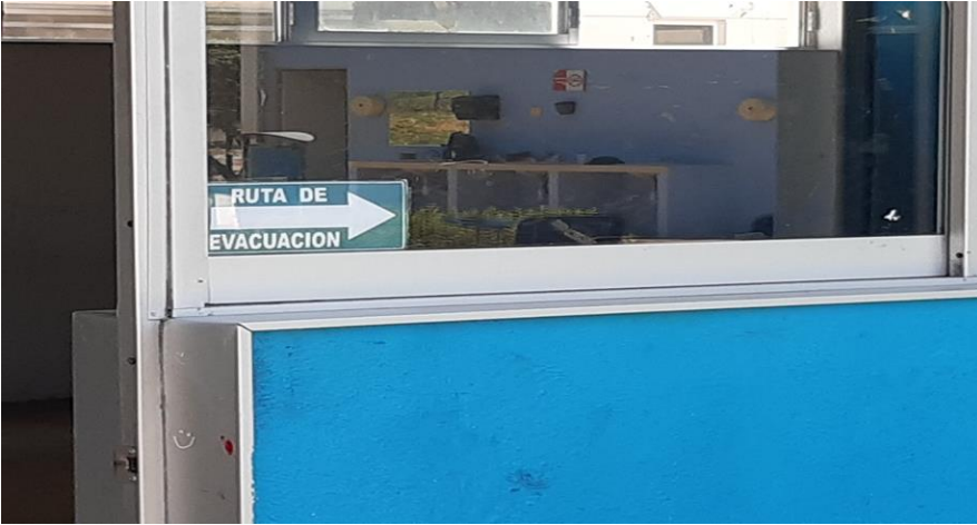
IMAGEN#13 COLOCACION DEL LETRERO DE RUTA DE EVACUACION
