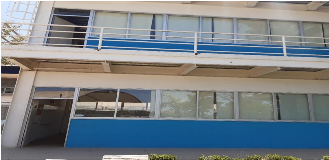
IMAGEN#9 DESPUES DE REFORRAR LA SEGURIDADE DE LOS BARANDALES
