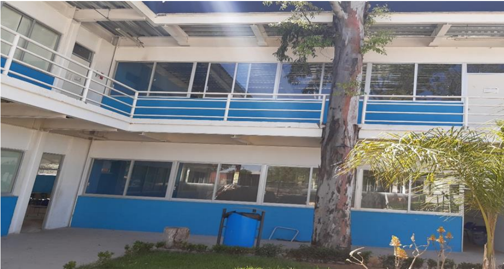
IMAGEN#10 ANTES DE REFORZAR LA BASE DE LOS PASILLOS
